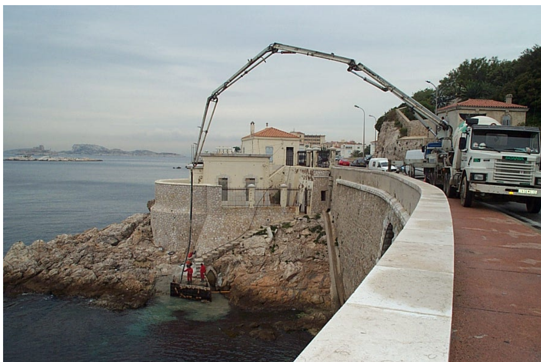
Les travaux d'avril 2001.
