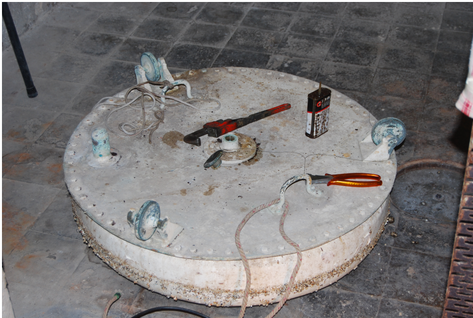
Le flotteur sorti du puits pour une opération de maintenance en mai 2011.
