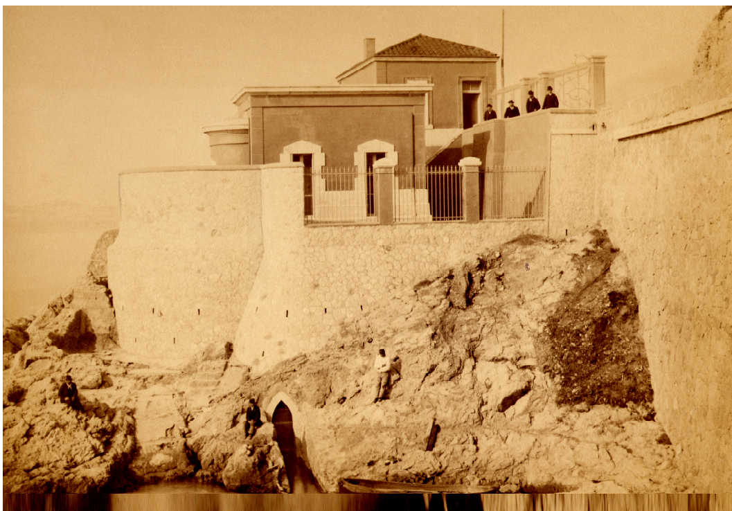
Photographie prise en janvier 1885 par Adolphe Terris, photographe attitré de toutes les administrations marseillaises de l'époque. Charles Lallemand et Christian Dennert figurent très probablement parmi les 4 hommes qui posent sur la terrasse.
