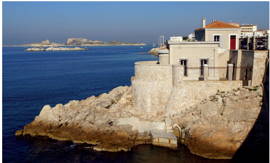
Figure 1. Le marégraphe de Marseille vu depuis la corniche du Président-John-Fitzgerald-Kennedy. La porte d'entrée de la galerie est visible à droite de la plateforme, en bas de l'escalier. Crédit : Les Amis du marégraphe de Marseille (2022).
