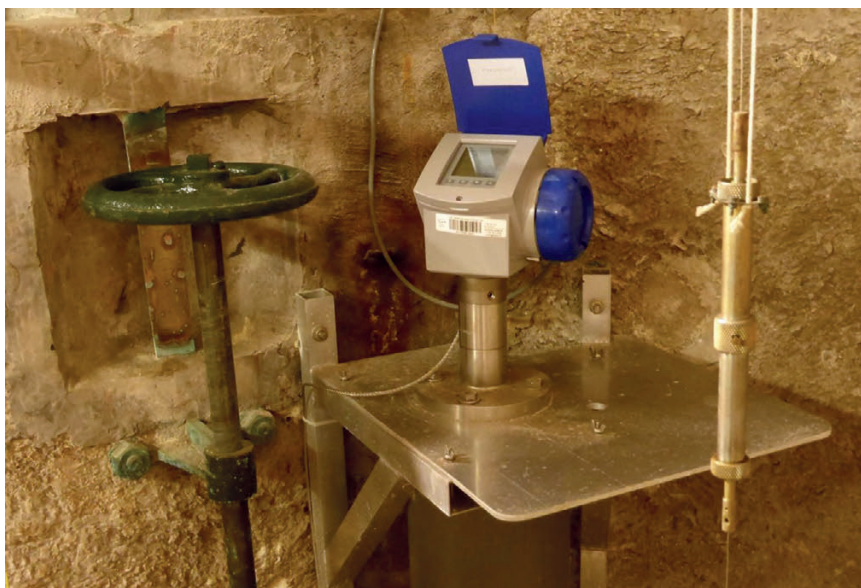
Figure 5. Le marégraphe côtier numérique aujourd'hui en fonctionnement à Marseille. À gauche, le volant d'ouverture de la porte intérieure de la galerie. À droite, le câble reliant le flotteur au marégraphe mécanique. Crédit : Les Amis du marégraphe de Marseille.
