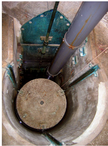
Figure 3. Le puits du marégraphe et ses trois rails qui guident le flotteur verticalement. On voit aussi la porte en bronze donnant sur la galerie qui communique avec la mer. Crédit : Les Amis du marégraphe de Marseille (2022).
