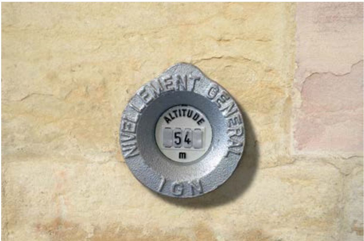
Figure 2 : Repère de nivellement de type médaillon - © IGN
