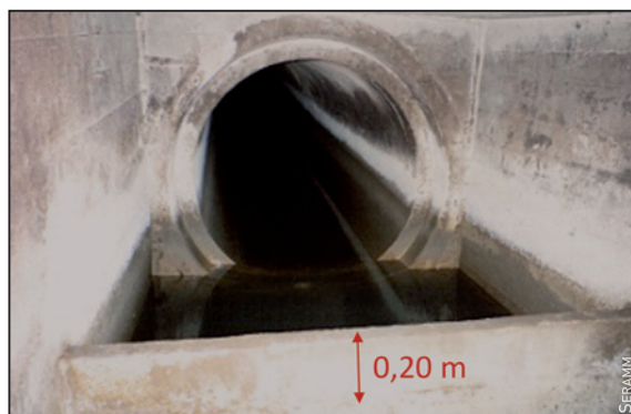
Figure 7. Rehausse de 20 cm réalisée sur les déversoirs en 2010
