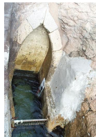
Fig. 3 : échelle de marée à l'entrée de la galerie de communication du puits avec la mer.
