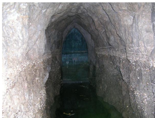
Figure 7 : la galerie du marégraphe de Marseille et la porte en bronze.
