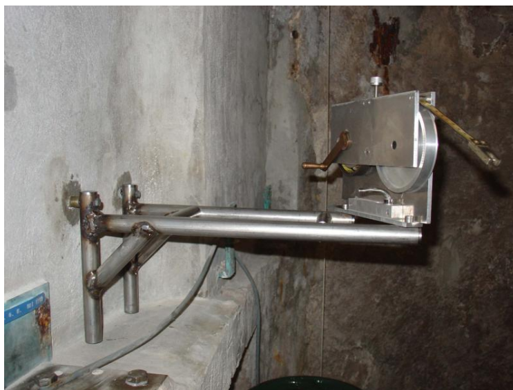
Fig. 9 : installation du portique et du dévidoir du ruban porte-sonde au-dessus du puits.
