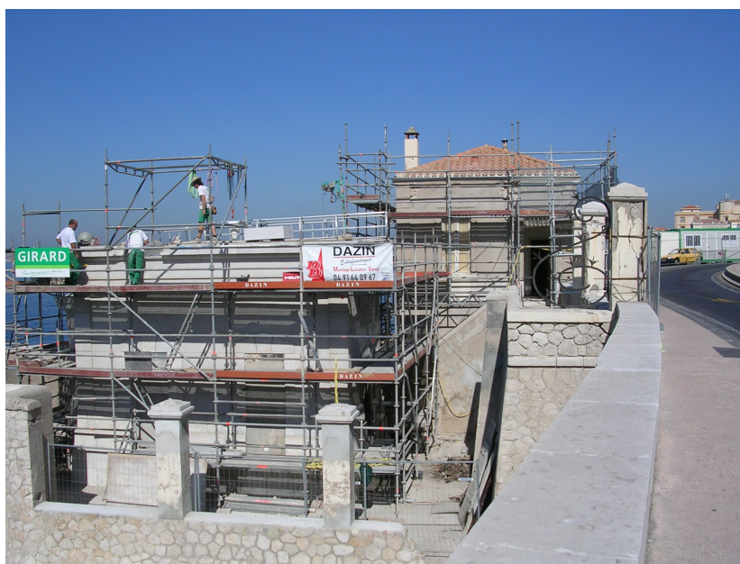
Les bâtiments du Marégraphe en juin 2006 - photographie réalisée par Franck Vergne (IGN).
