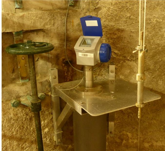
*À gauche, Bernard Croguennoc en plein travail. À droite, l'émetteur d'ondes radar Krohne Optiflex 1300C du marégraphe côtier numérique actuel, installé dans la chambre souterraine, au-dessus du puits de tranquillisation. Les ondes radar sont émises en direction de l'eau et réfléchies par sa surface. Le temps de propagation aller-retour est mesuré et transformé en hauteur. La référence est le dessus de la plaque horizontale en aluminium.*
